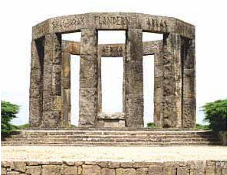
Das Hünenborgdenkmal auf dem Thieberg in Rheine
